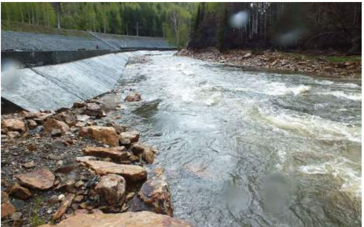
Фото 6.36. Входная часть несложная, на уровне 2 к.т.
