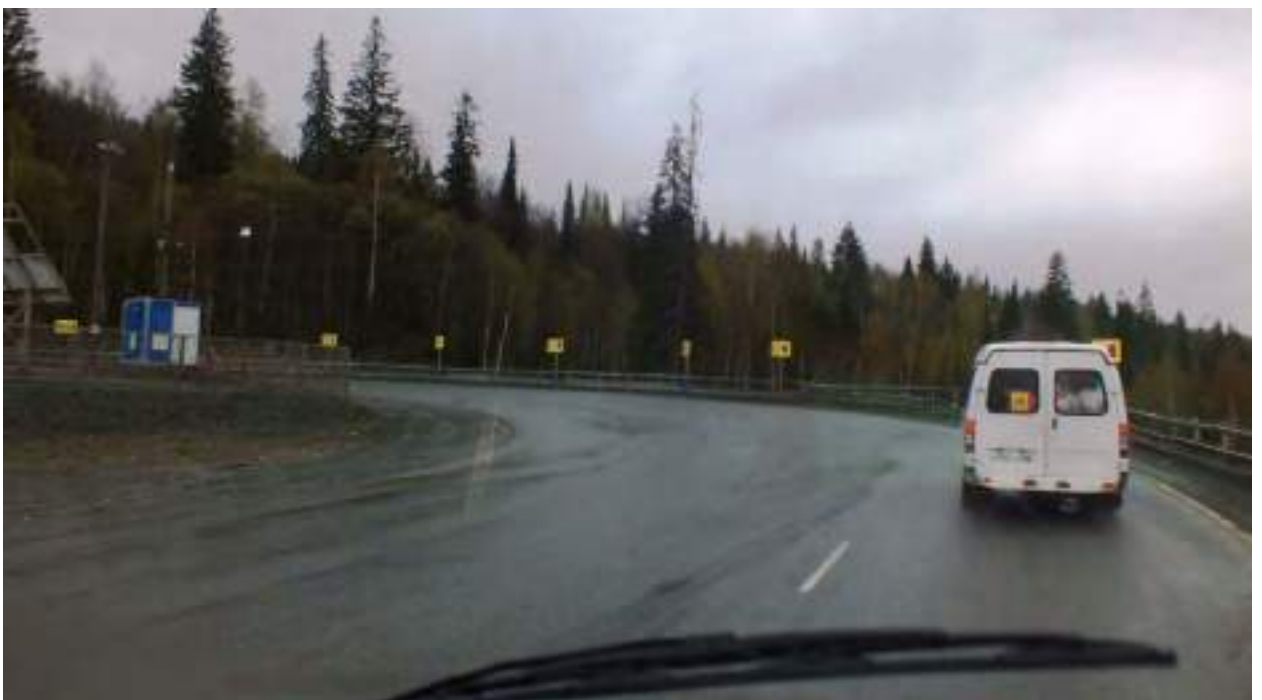
Фото 1.11. Входим в левый поворот на «Тещин язык»
