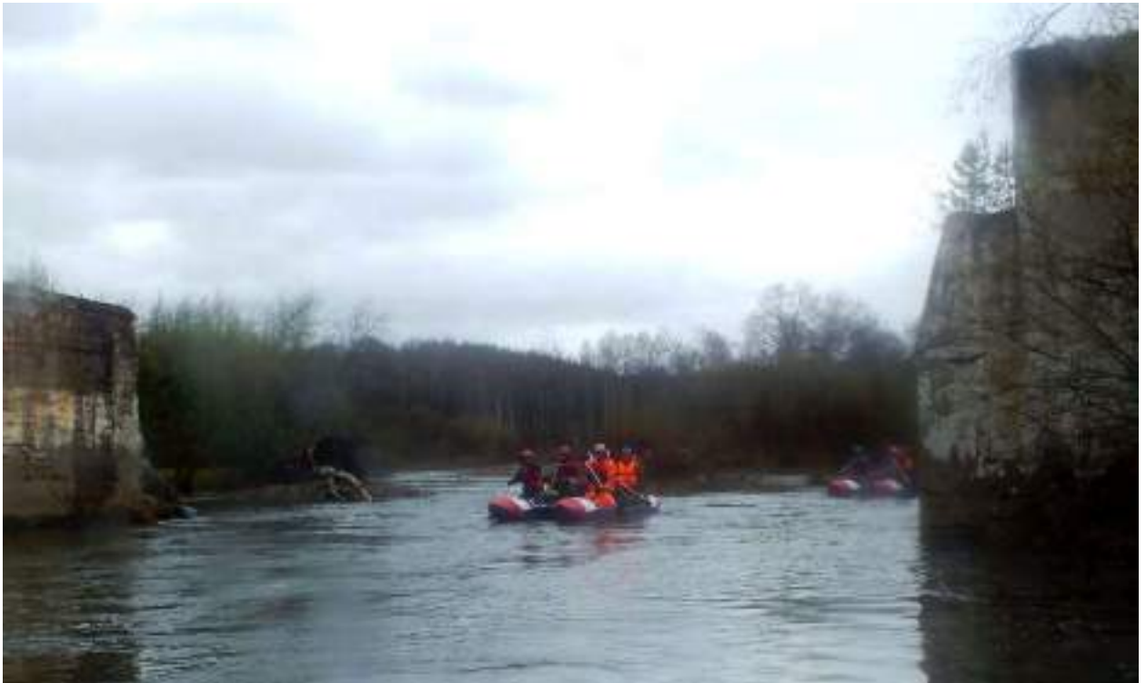
Фото 2.08. Проходим опоры разрушенного моста
