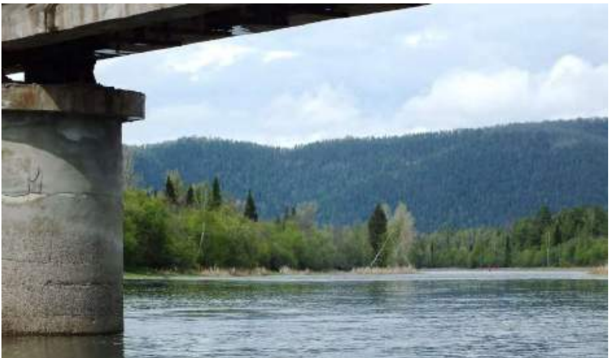
Фото 5.16. Проходим второй мост на этом участке.
